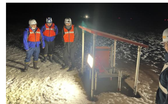
▲稚内空港／巡回灯LED化工事
